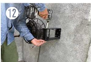
インパクト用ソケット17mmとスパナ17mmを使用しボルトを固定します。締め付け具合でブラケットの回転重を調整してください。
