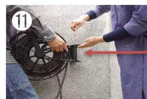
本体軸をブラケットの間に差し込みボルトで固定します。
