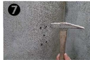
コンクリートプラグを挿入。ハンマーでコンクリート面まで打ち込みます。
