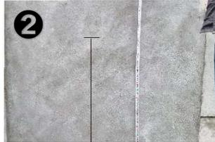
取付位置のを決めます。推奨の取付高さは台座中心がH600~800です。800以上には取り付けないでください。塙の下地をしっかりと強度を確認したうえで決定してください。
