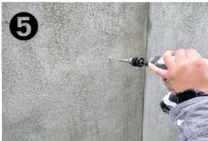
ハンマードリル・振動ドリルを使用しコンクリート用ドリルビットでプラグ用(10mm)下穴を掘ります。
