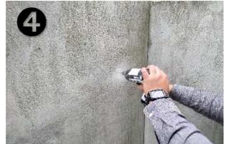
ハンマードリル・振動ドリルを使用しコンクリート用ドリルビット(3.4~4.0)小さめの下穴を掘ります。
