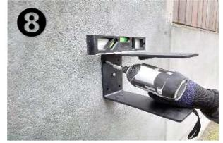
インパクト用ソケット10mmを使用しネジを締め付けていきます。その際、ブラケットの水平も確認します。
