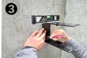
取付場所が決まったら台座を壁に充て水平を確認しながら下穴の位置に鉛筆などで印をつけます。
